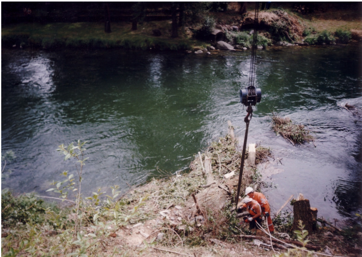
Giugno 2006 intervento a Sabbio Chiese
