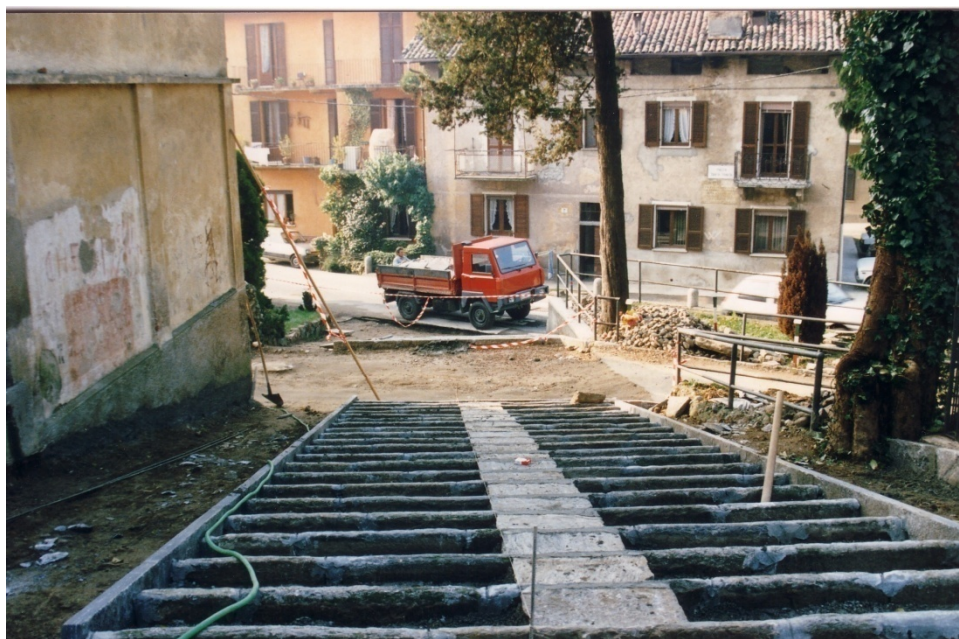
La vecchia rizzada è stata completamente asportata
