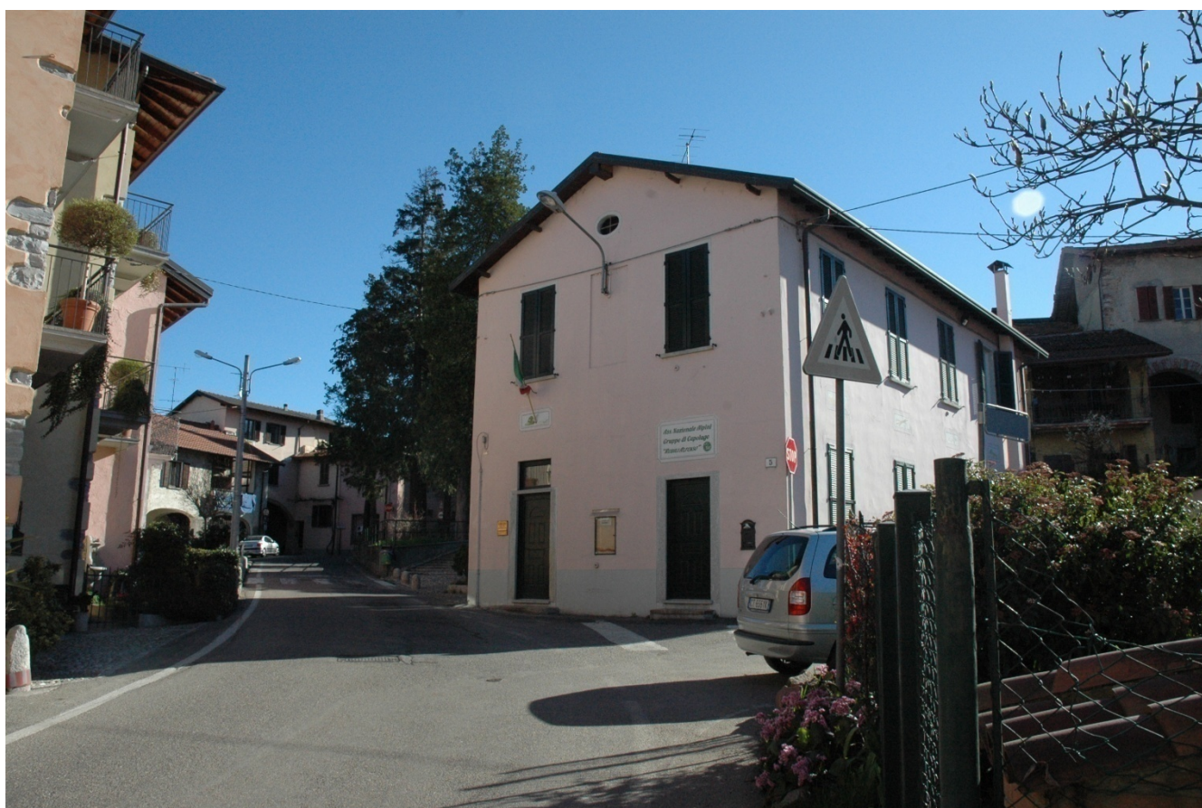
La nuova sede dopo la ristrutturazione – L'entrata
