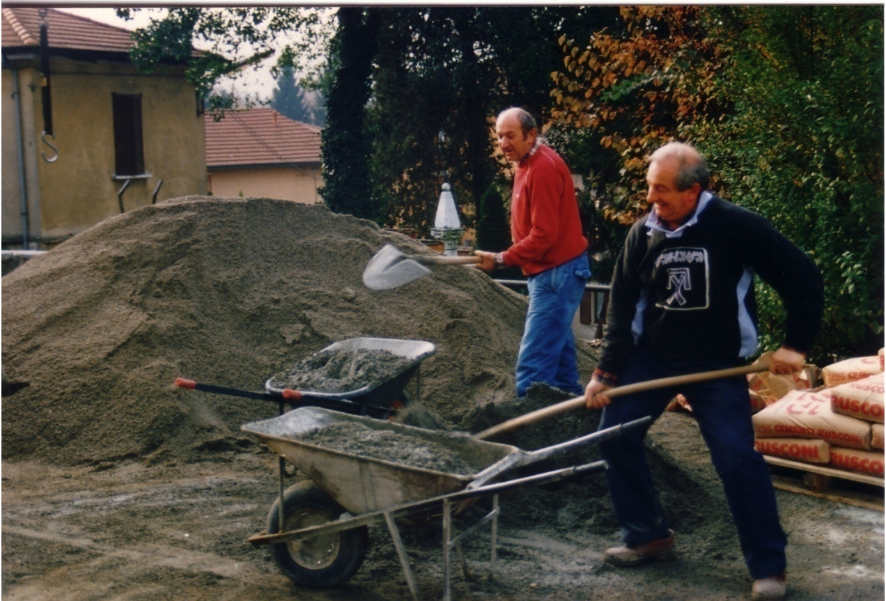
Iniziano i lavori – qui Ugo Ossola e Silvano Maineri
