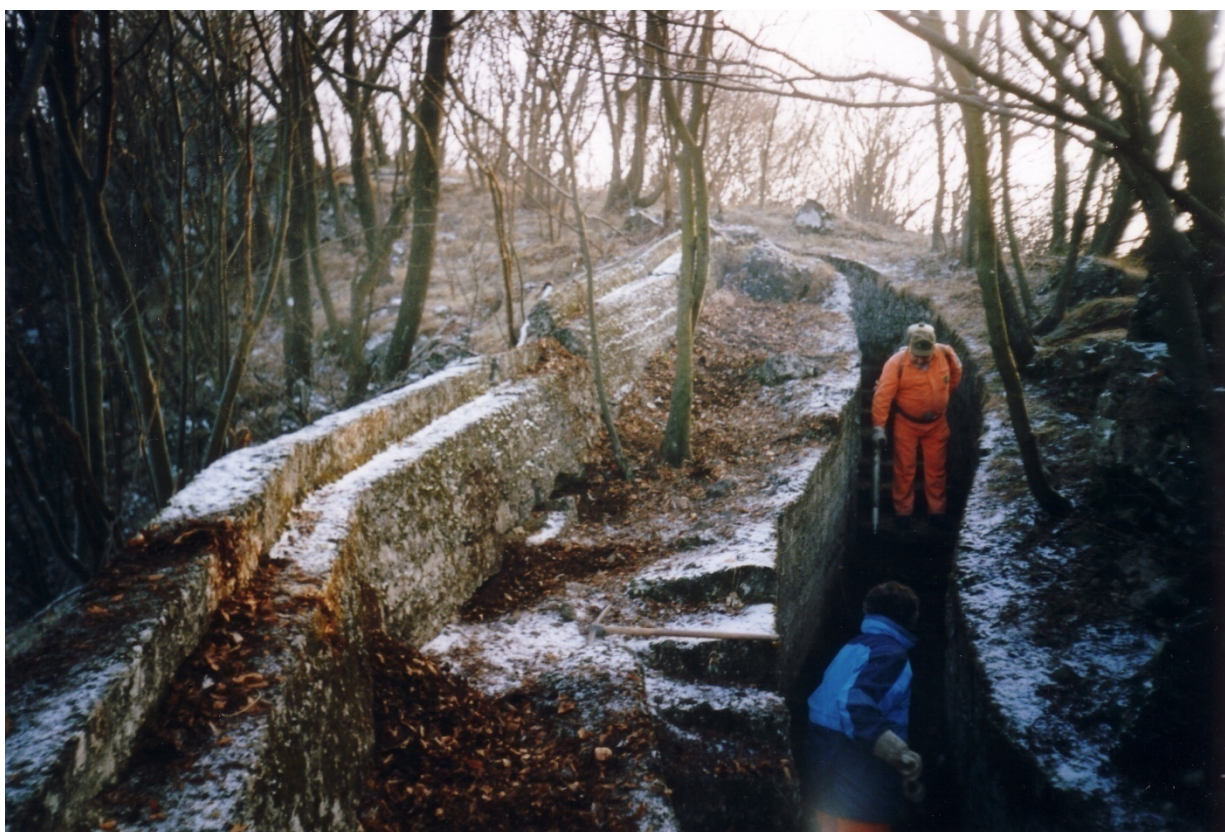
Febbraio 2005 – Intervento sulla Linea Cadorna
