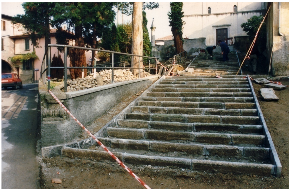
La vecchia rizzada è stata completamente asportata
