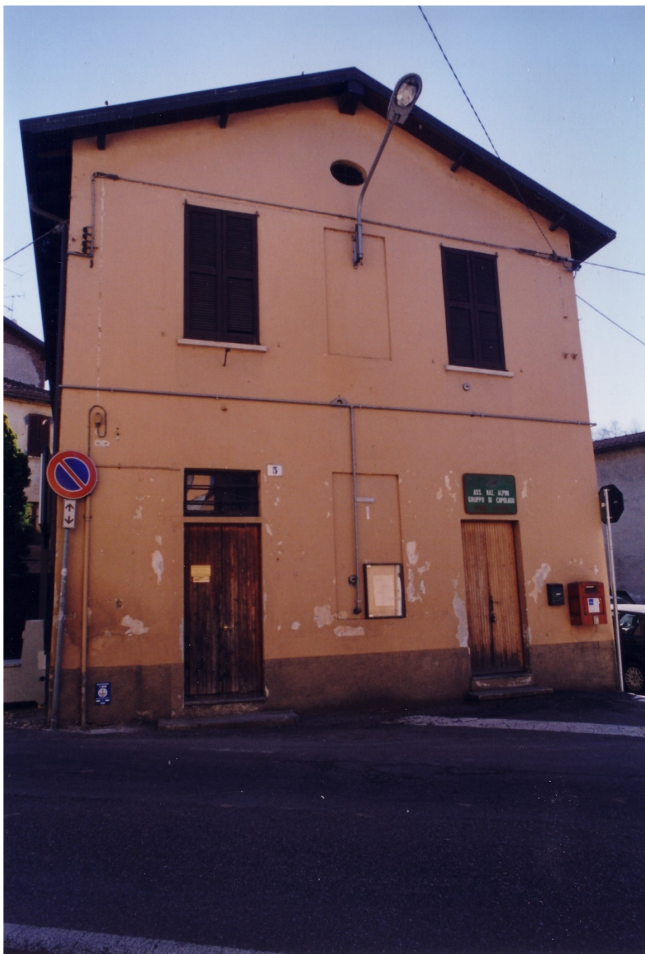
La Sede prima del restauro del 2004
